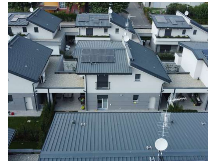
IMPIANTO FOTOVOLTAICO, VILLAGGIO VALERA
